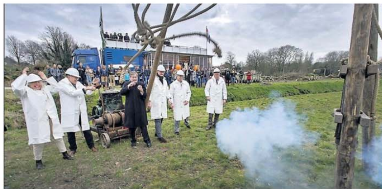
Begin van het bouwrijp maken van de grond.
